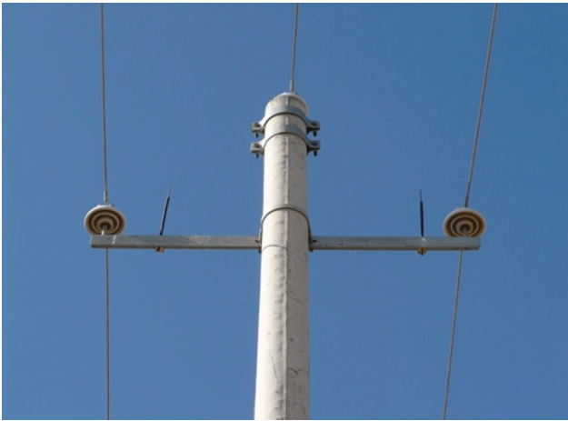
Зураг 9. 15кВ-ын шонгийн бүтэц (1, 2-phase to ground), (3-phase to phase)
