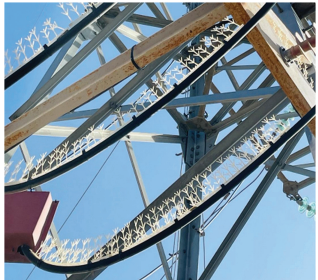
Зураг 14. Цахилгаан дамжуулах агаарын шугамын тулгууруудын буултын кабелиудад шувуу үргээгч өргөс суурилуулсан байдал
