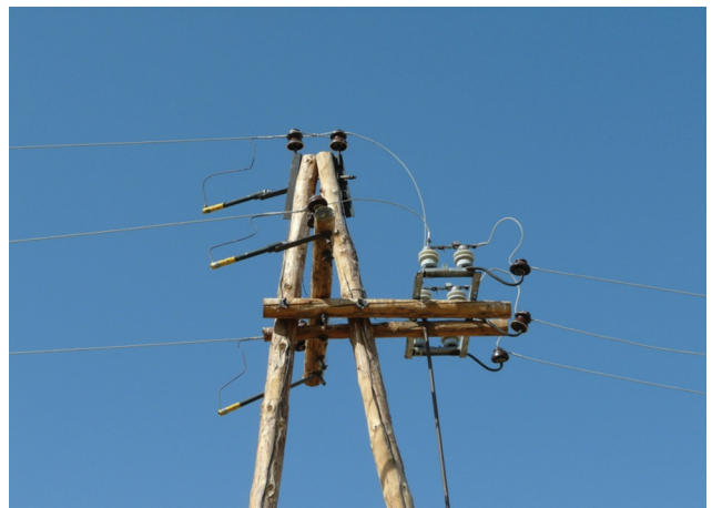
Зураг 8. 6 ба 10КВ-ын шонгийн бүтэц (1-phase to ground), (2-phase to phase)
