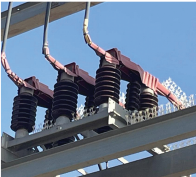
Зураг 14. Дэд станцууд болон тулгууруудын 35кВ-ын хуурай салгууруудын хөдлөх болон үл хөдлөх контактуудад “Cover” хийсэн байдал.
