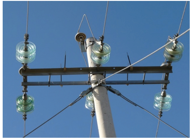
Зураг 9. 15кВ-ын шонгийн бүтэц (1, 2-phase to ground), (3-phase to phase)
