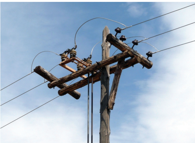
Зураг 8. 6 ба 10КВ-ын шонгийн бүтэц (1-phase to ground), (2-phase to phase)
