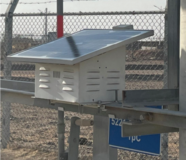
Зураг 15. Дэд станцуудын хөндлөвчүүд болон тулгууруудад дуут шувуу үргээгч байршуулсан байдал
